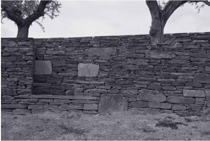
Figura 4 Escalera integrada en el espesor del muro.
